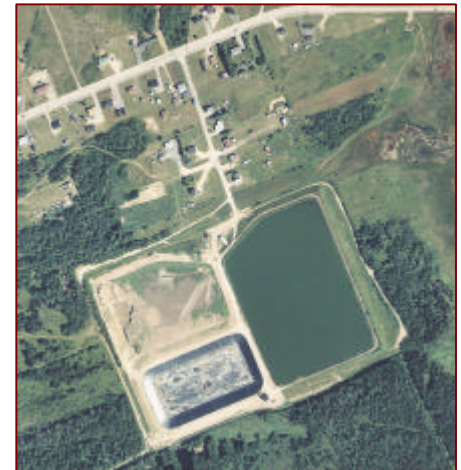
Usine de filtration et bassin de sédimentation de Bas-Caraquet
